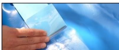
. Coloque la cinta adhesiva sobre la zona dañada.
